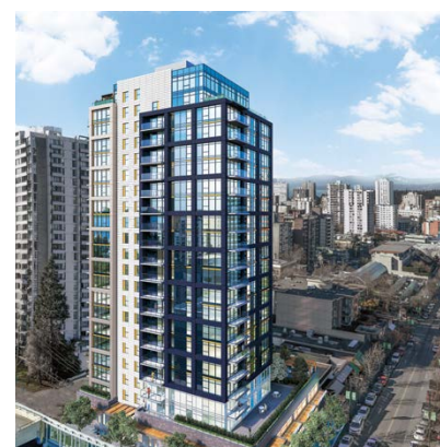
Immeubles résidentiels à logements multiples :
